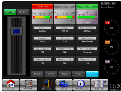
Medición del sistema, batería
