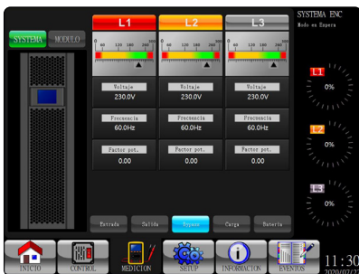
Medición del sistema, bypass
