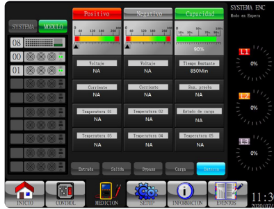
Medición del módulo, batería
